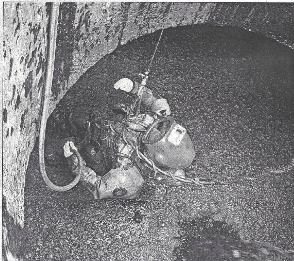
ABWÄRTS: Die Spezialtaucher erkunden Becken in den Kläranlagen. Dabei muss der Betrieb nicht unterbrochen werden. Das Foto zeigt den Faulturm in Waghäusel. Foto: ...
