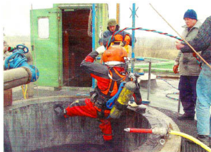
Abb. 1: Über eine spezielle Senk- und Hebevorrichtung wird der Taucher mit druckluftbetriebener Mann-Winde in den Faulturm hinabgelassen – Atemluftversorgung und Sprechkontakt erfolgen über spezielle Schläuche
