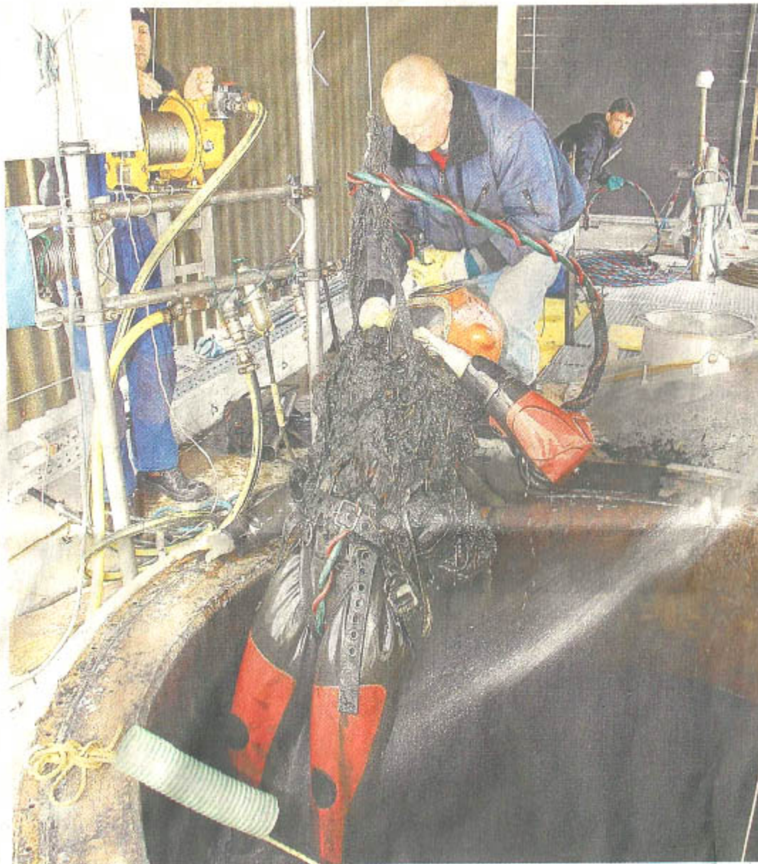
Mit einer Seilwinde wird der Taucher nach zwei Stunden herausgezogen.
